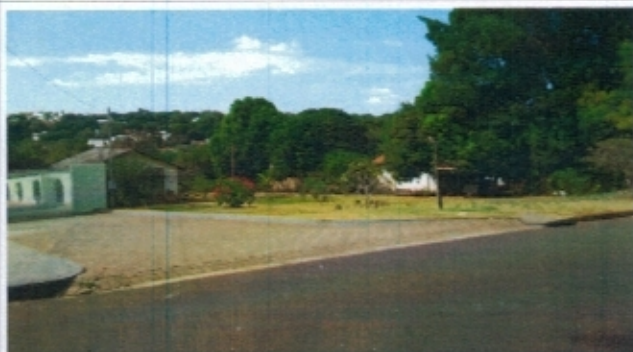
04-Trecho entre Av. Sabiá e Gralha Azul na Av. Pintassilgo
