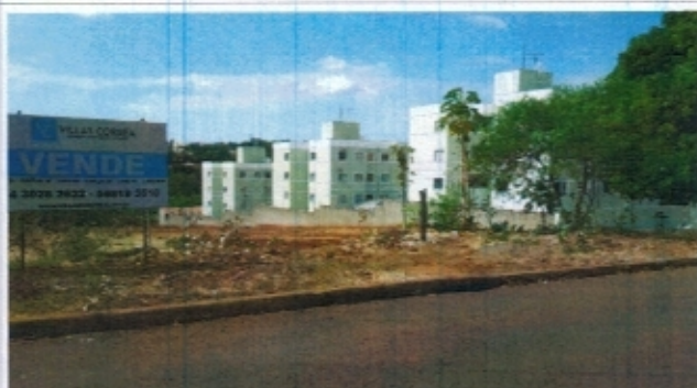
06-Trecho entre Av. Sabiá e Gralha Azul na Av. Pintassilgo
